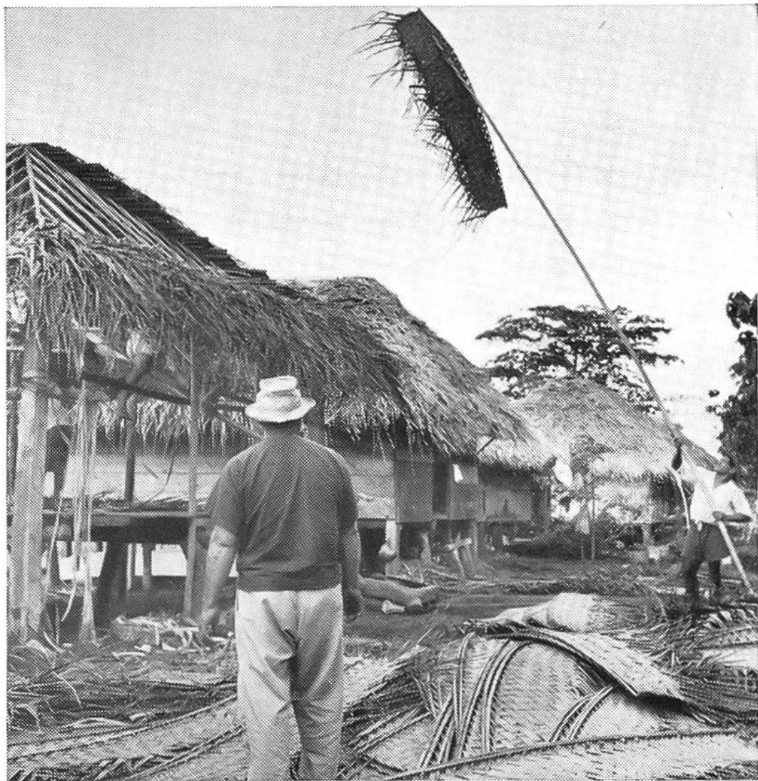
Le stuoie vengono issate sul tetto mediante lunghe pertiche.
