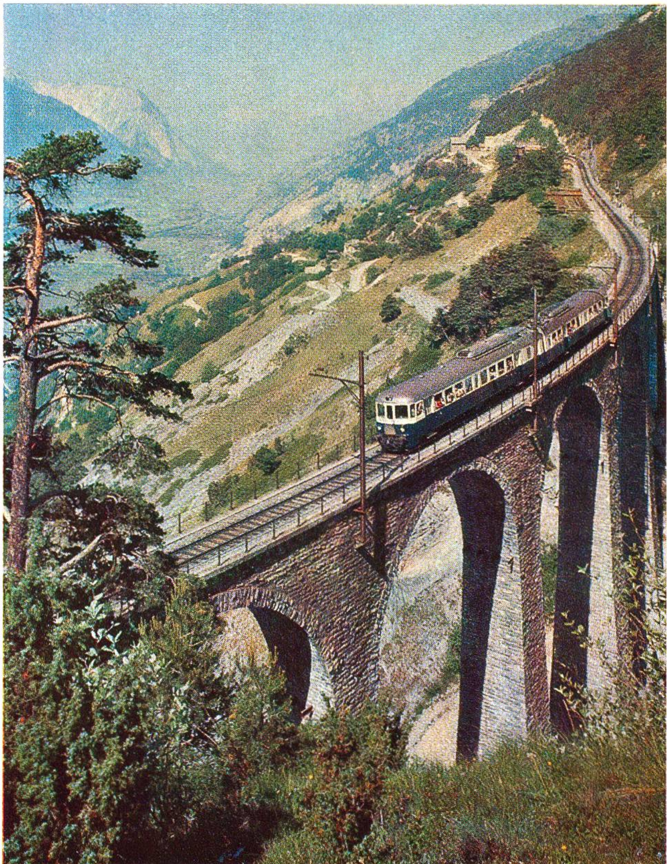
Eines der imposantesten Bauwerke der Lötschbergbahn ist der 50 m hohe und 116 m lange Luogelkinviadukt auf der bei Hohtenn in 450 m Höhe über dem Rhonetal sich hinziehenden Südrampe, eine der schönsten Eisenbahnstrecken der Schweiz. BLS-Leichttriebkomposition auf der Fahrt nach Stresa (Italien).
