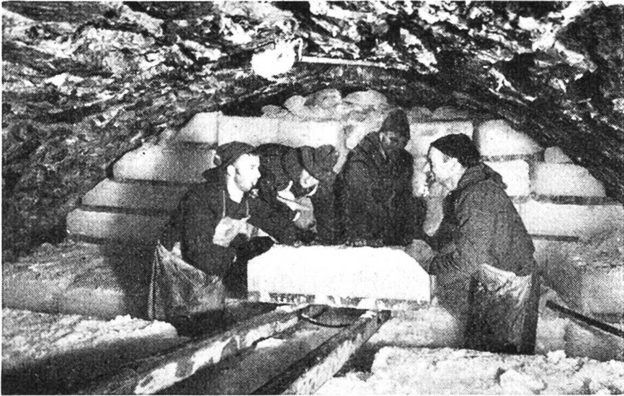
Einlagerung von Klöntalersee-Eis in einem Eiskeller.
