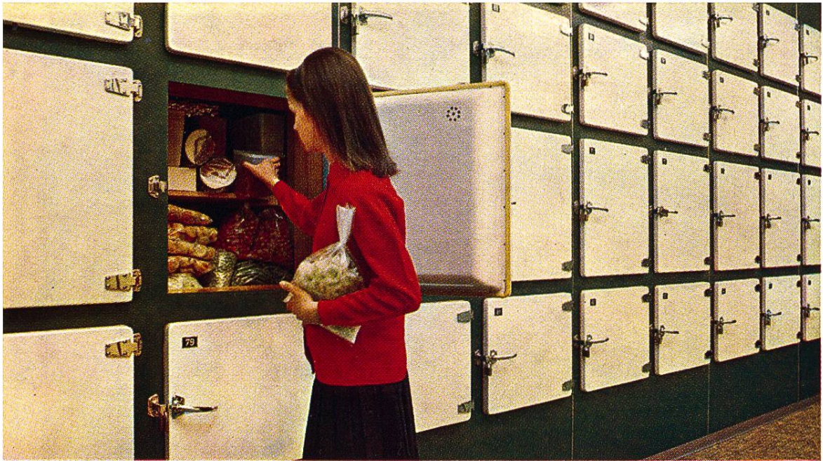
Therma-Tiefkühlanlage in Benken (Kanton Zürich). Das Tiefkühlgut wird zum Schutze vor Austrocknung in Plastik-Beuteln eingelagert.
