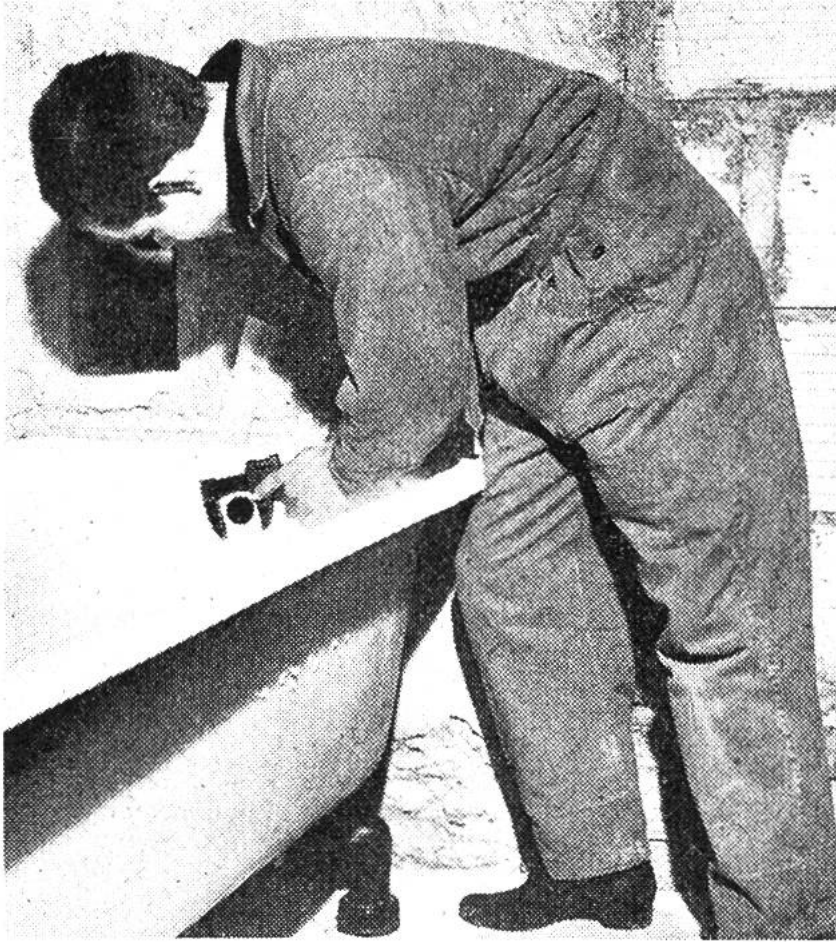
Eine Badewanne wird montiert.
