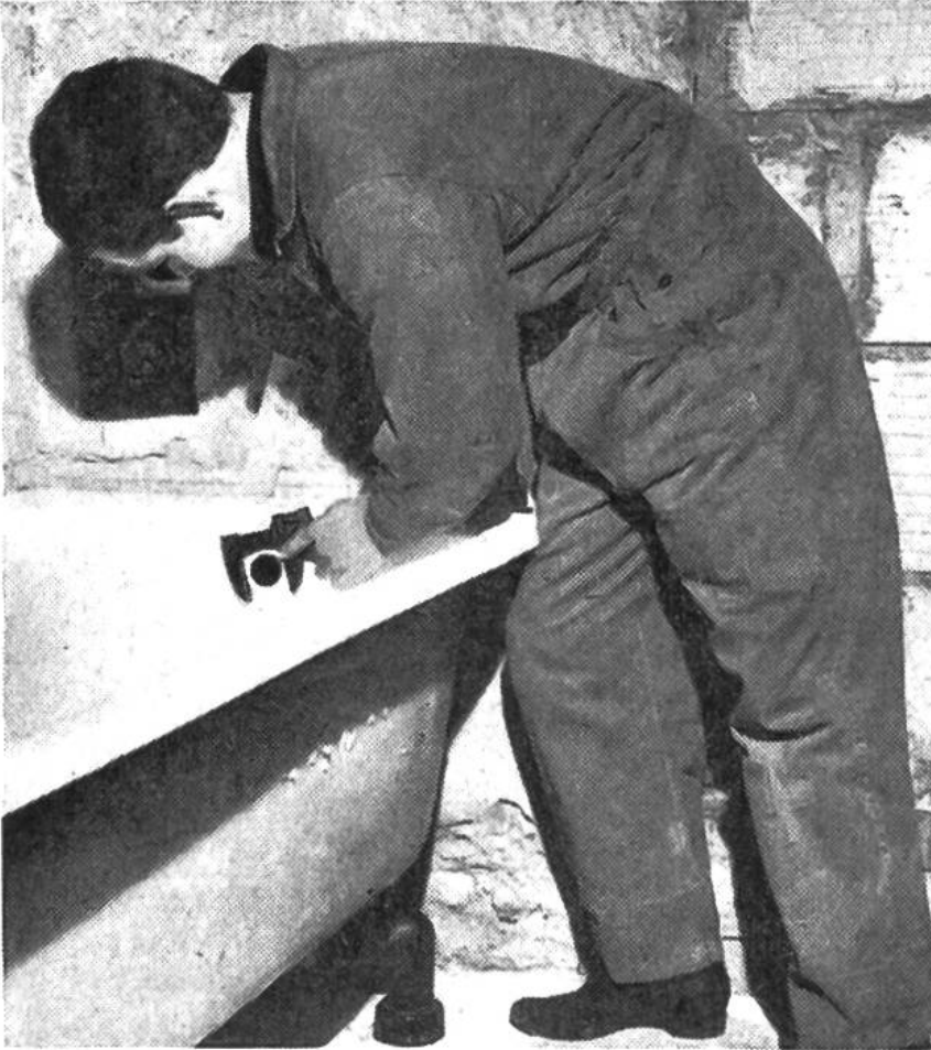
Eine Badewanne wird montiert.
