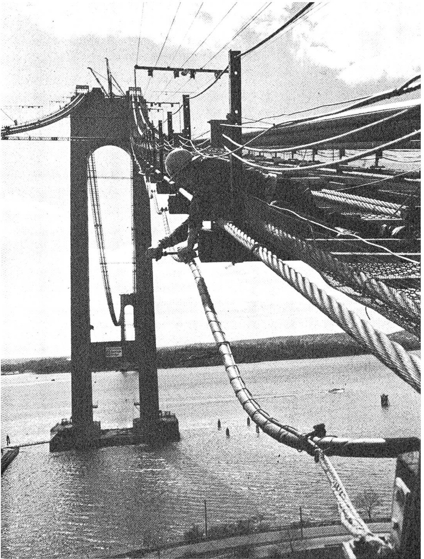
Mohawk-Indianer sind bekannt als furchtlose Spezialisten bei der Erstellung luftiger Stahlkonstruktionen.
