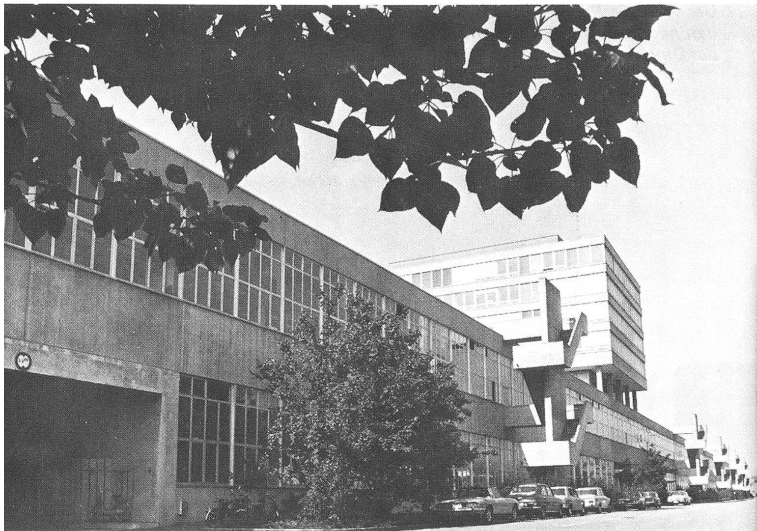
Das riesige Gebäude von Jelmoli-Otelfingen, wohin das Schreiben von Urs adressiert ist.
