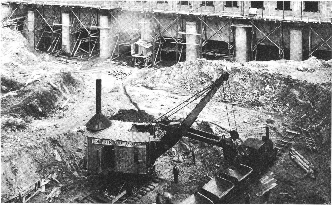
Das Maschinenhaus mit dem Ablaufkanal während der Bauzeit. Nur wenige — längst nicht so leistungsfähige — Maschinen wie man sie heute kennt, standen den Arbeitern zur Verfügung.
