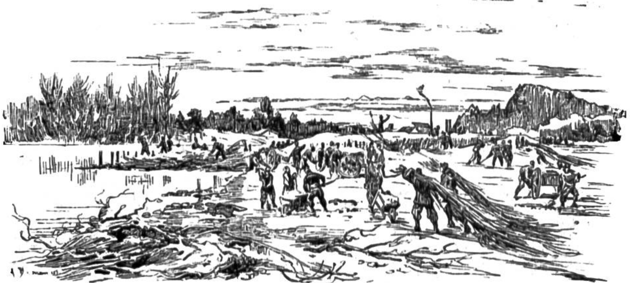
Internierte arbeiten an der Korrektion der Emme bei Solothurn.
