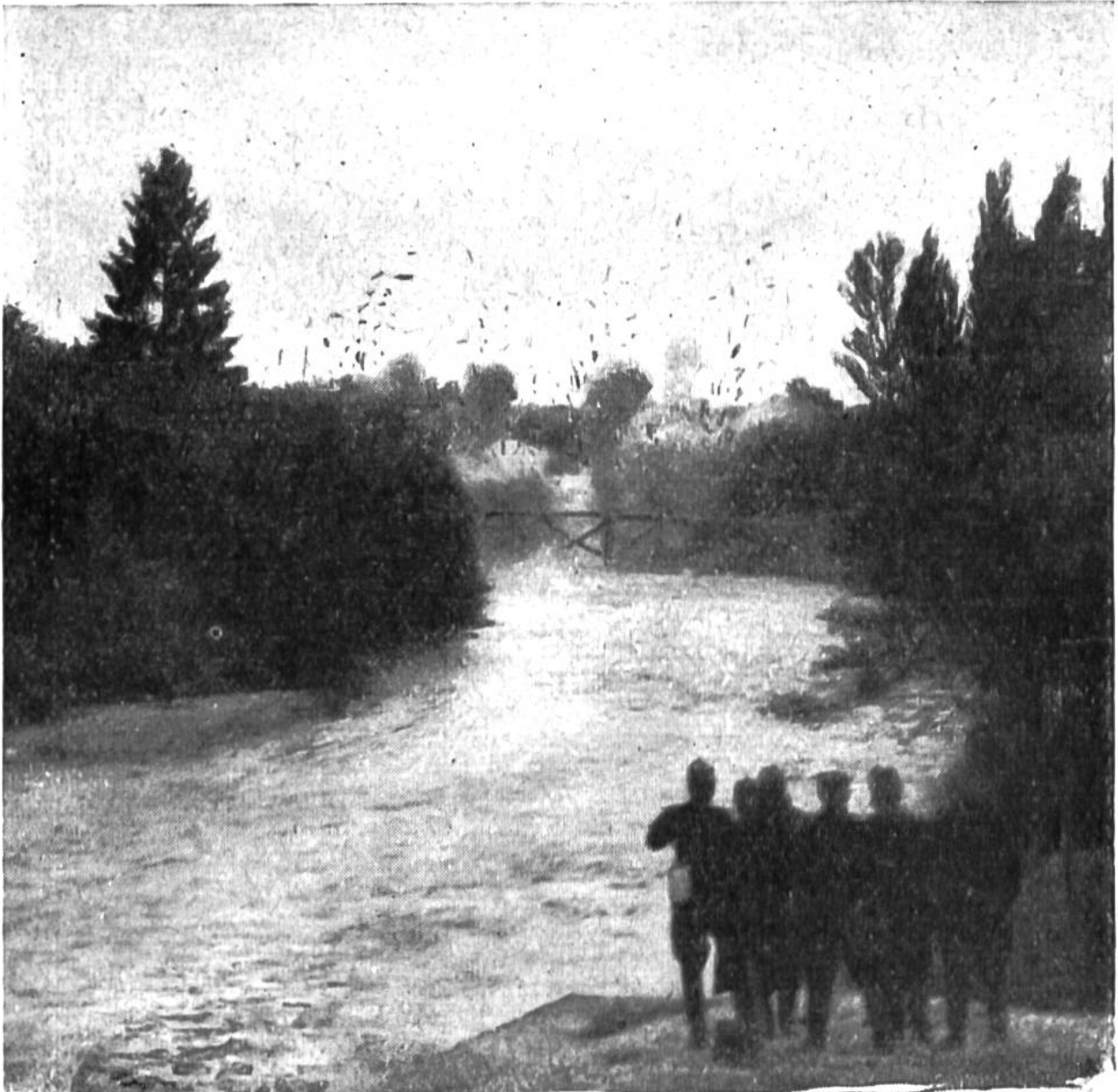
Sprengen einer Brücke.
