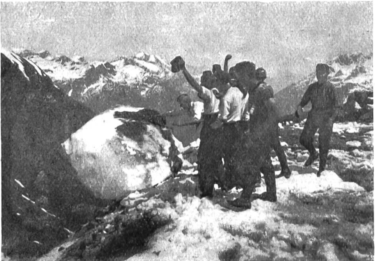
Abschied vom Winter: letzte Schneeräumungsarbeit.
