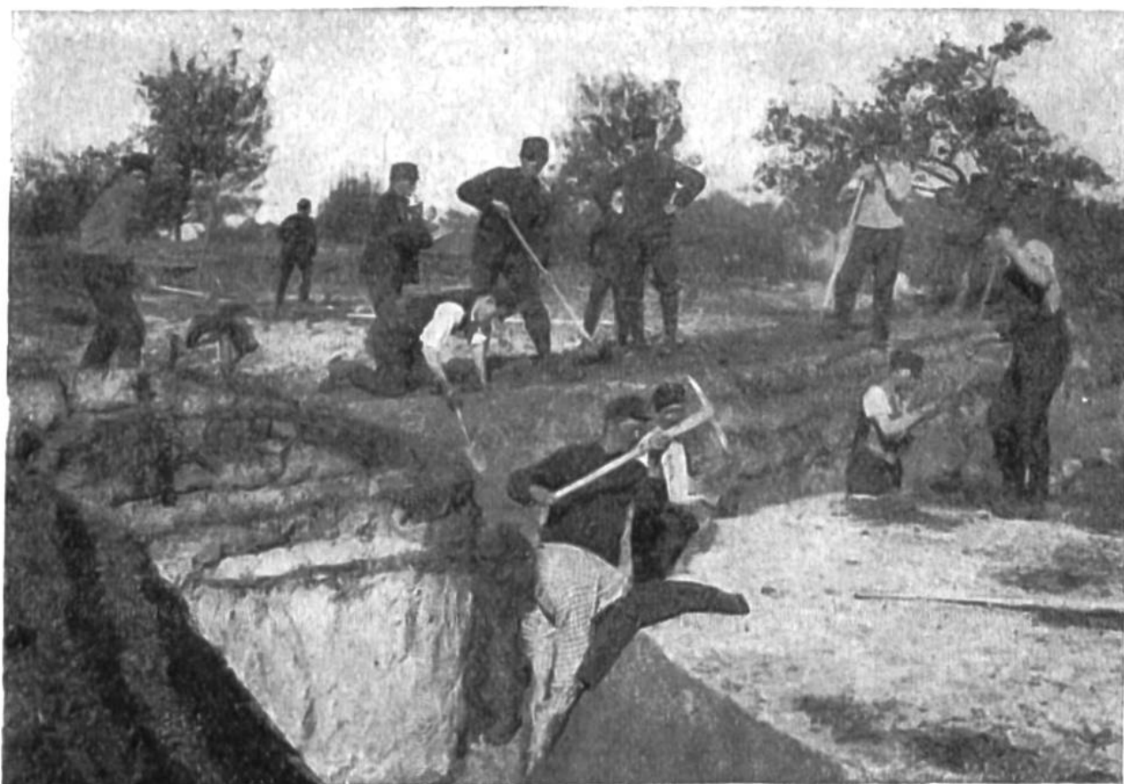
Ausheben von Schützengräben.
