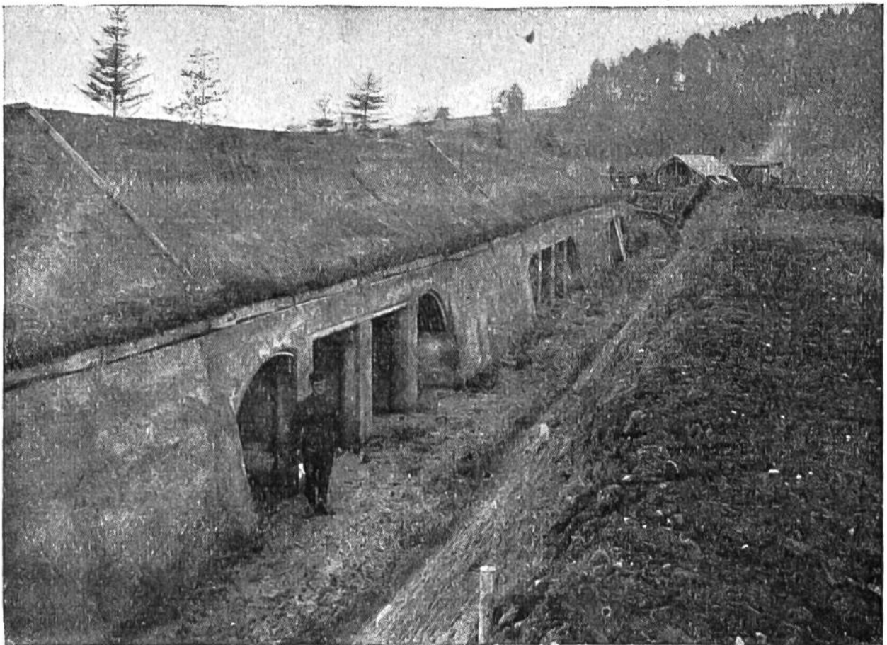
Kehlgraben mit Unterständen in einem Stützpunkt.
