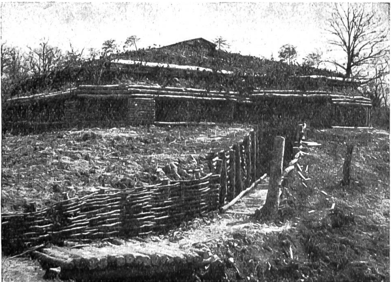
Eingang zu einem Blockhaus.
