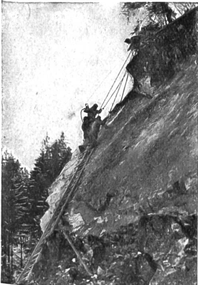
Schwierige Bohrarbeiten. — Strassenbau an der Pierre-Pertuis.
