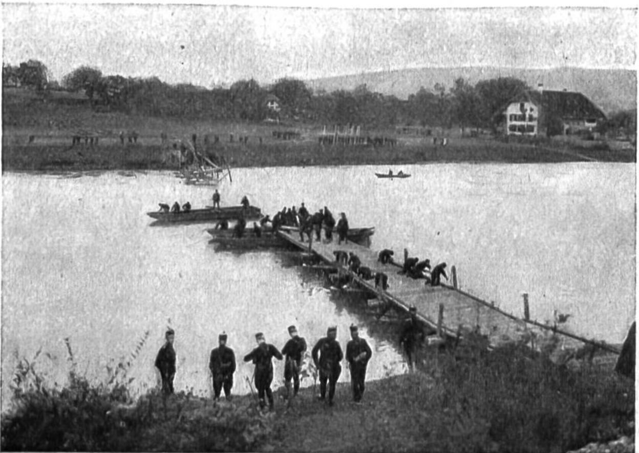
Bau einer Schiffsbrücke.
