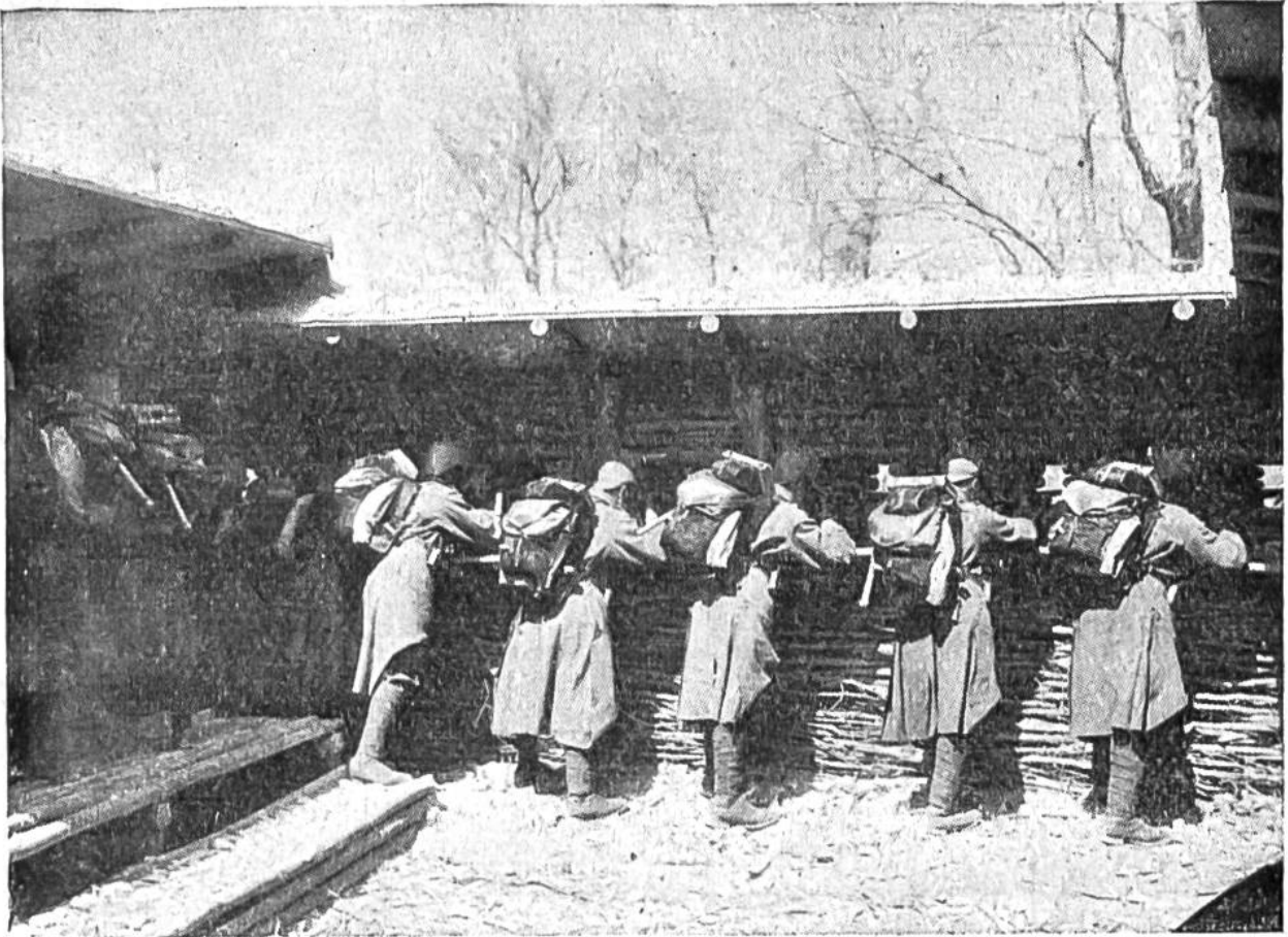
Innenansicht eines Blockhauses. Besetzte Feuerlinie an der elsässischen Grenze.
