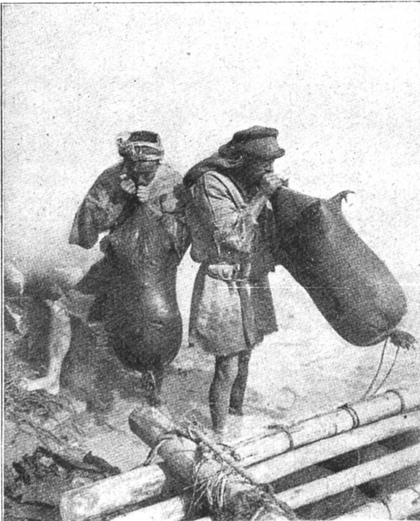
Die Tierhäute werden aufgeblasen, um unter dem Floss, dem „Kelck“, befestigt zu werden.
