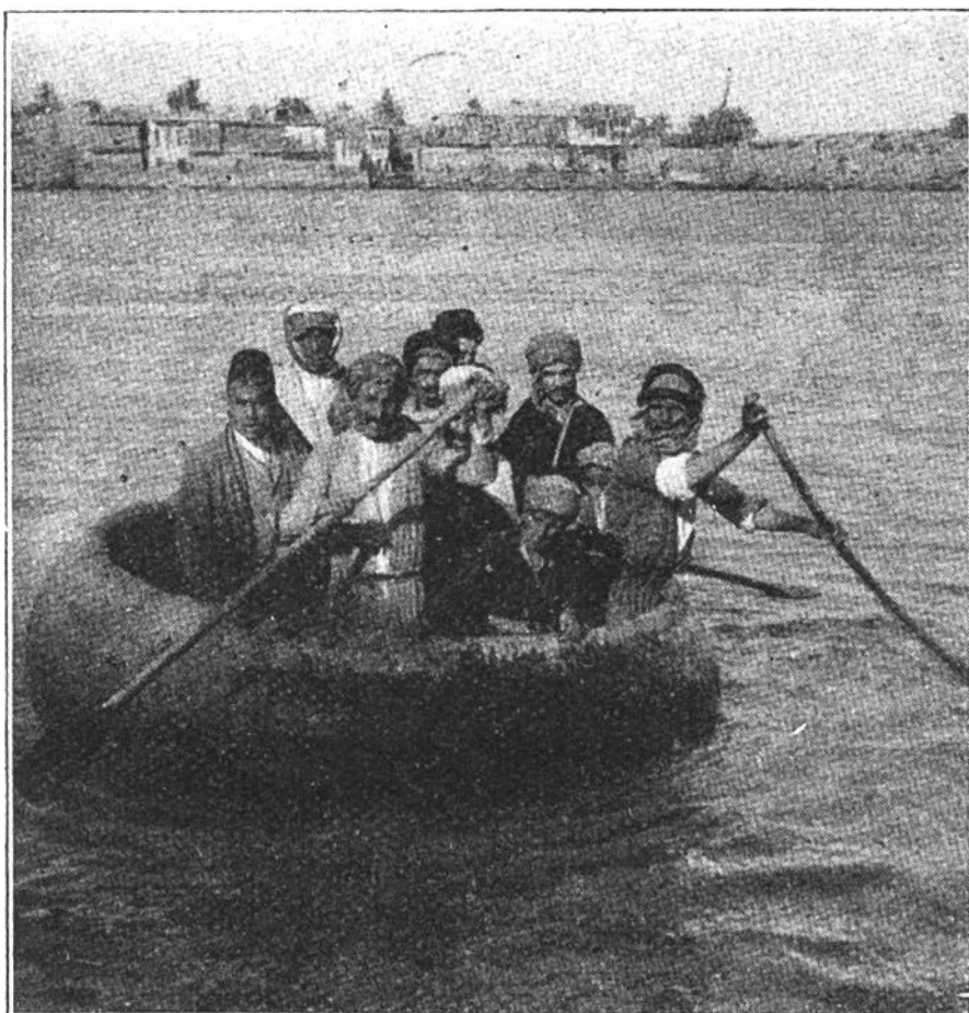
Ein „Kelck“, d.h. ein Floss, das von aufgeblasenen Tierhäuten getragen wird, fährt mit Reisenden und Fracht von Diarbékir nach Mossoul den Tigris hinunter.
