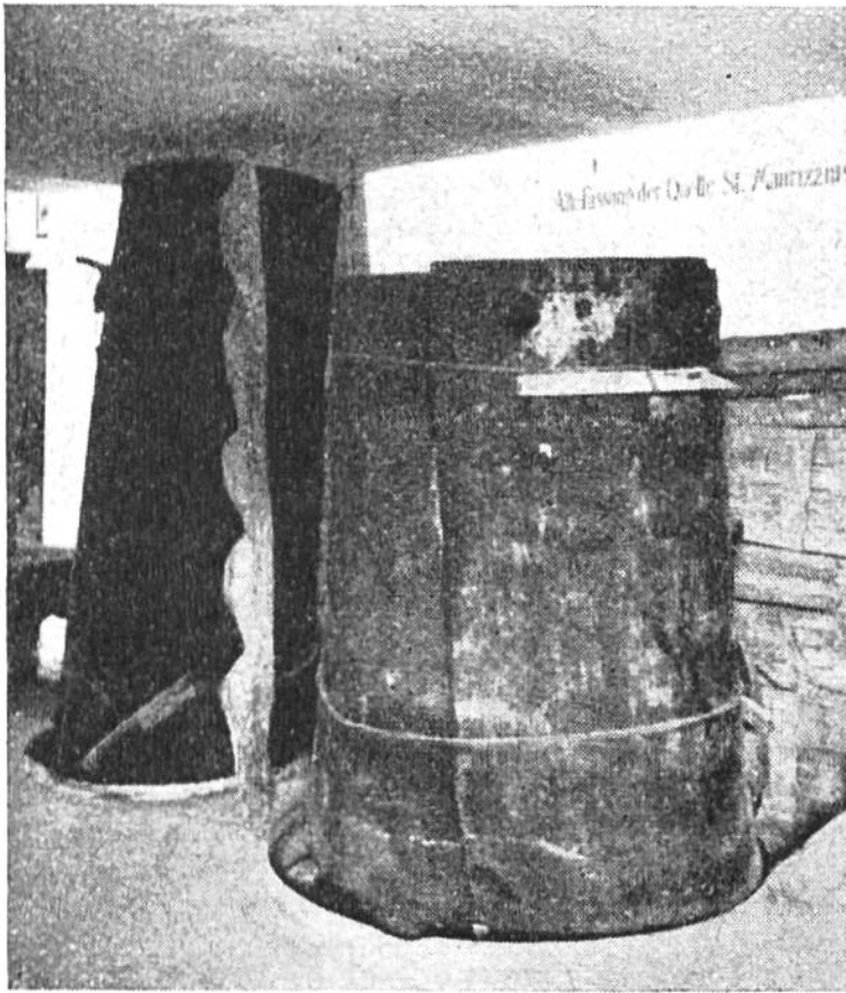
Die beiden ausgehöhlten Lärchenstämme, welche 3000 Jahre lang der Quelle als Fassungen gedient hatten.
