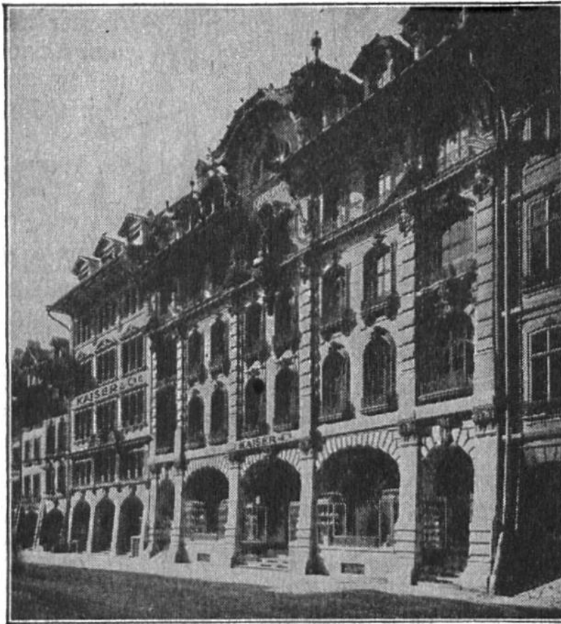
Teilansicht der Geschäftshäuser Kaiser & Co. A.-G. Marktgasse 37—43 durchgehend Amthausg.
