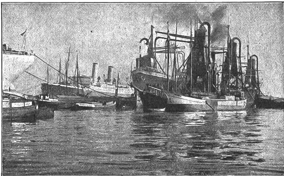
Getreide wird aus den Frachtdampfern mittels Saugrohren verladen. Bild aus dem Hamburger Hafen.
