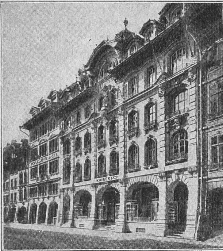
Teilansicht der Geschäftshäuser Kaiser & Co. A.G. Markt g a s s e 37-41, A m t h a u s g a s s e 22-26.
