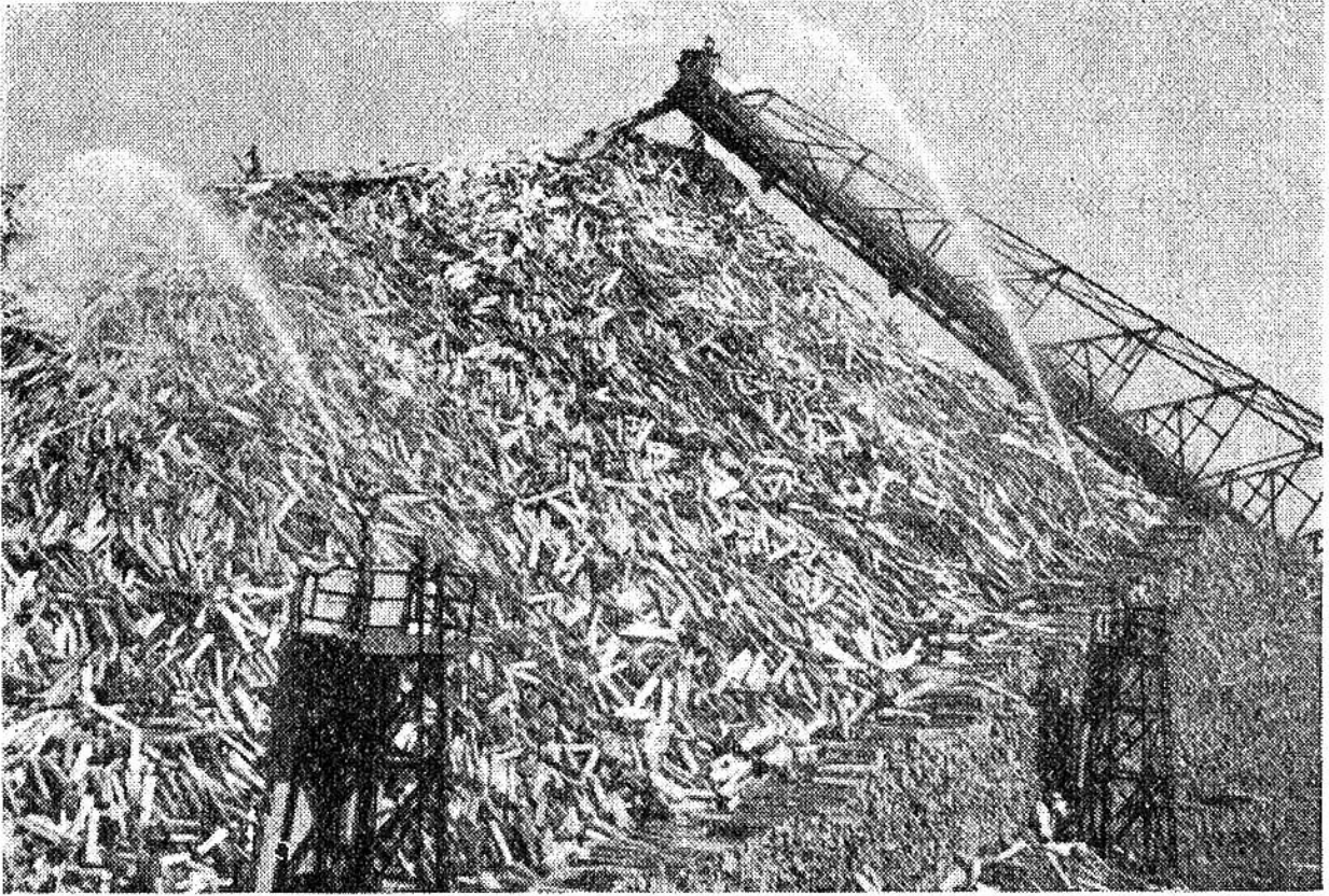
Hydranten schützen ein grosses Papierholzlager vor Selbstentzündung.
