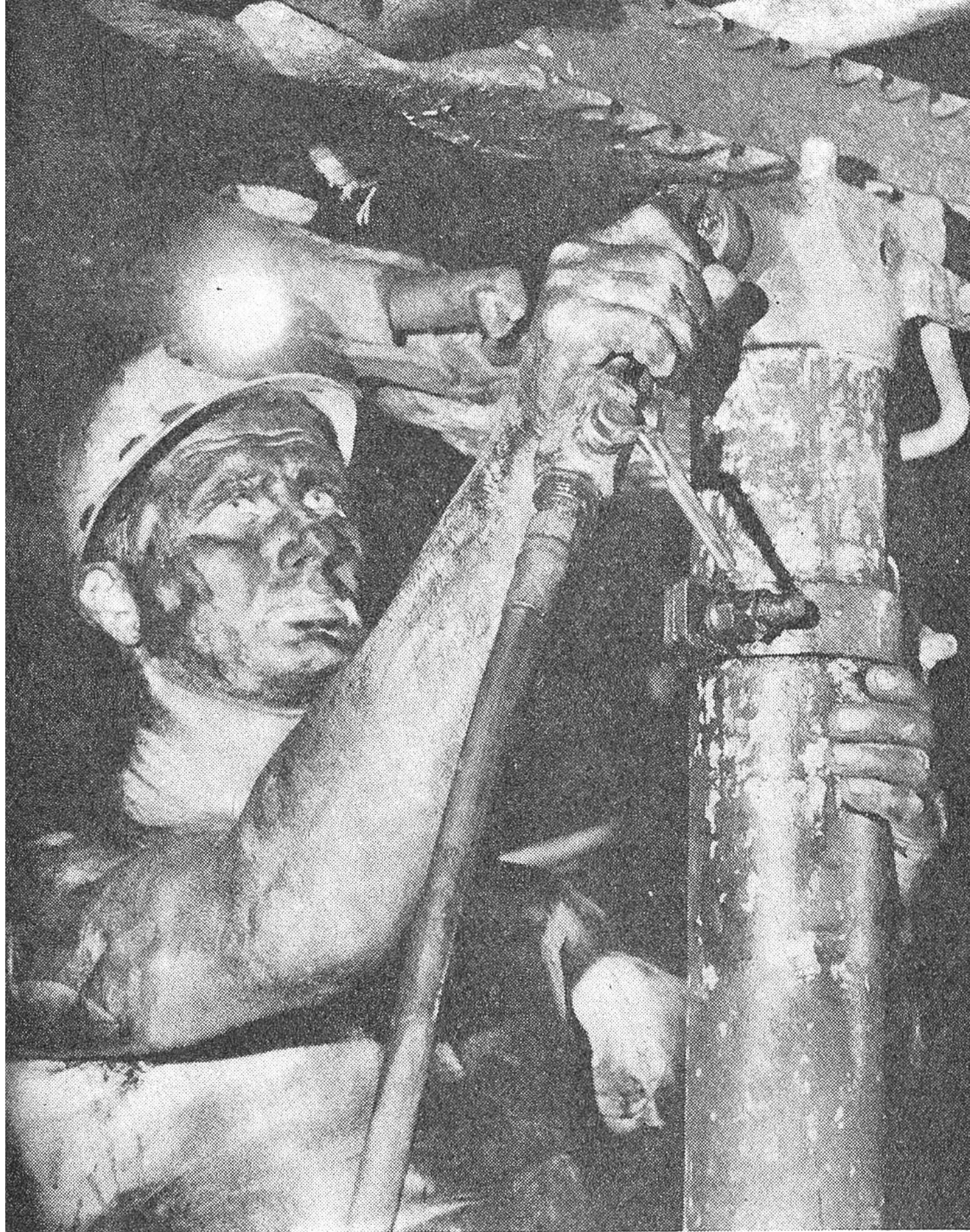
Ganz besondere Aufmerksamkeit muss der Abstützung der Stollendecken geschenkt werden. Hier passt ein kohlungeschwärzter Bergmann einen Stempel (Stützpfehl) ein.
