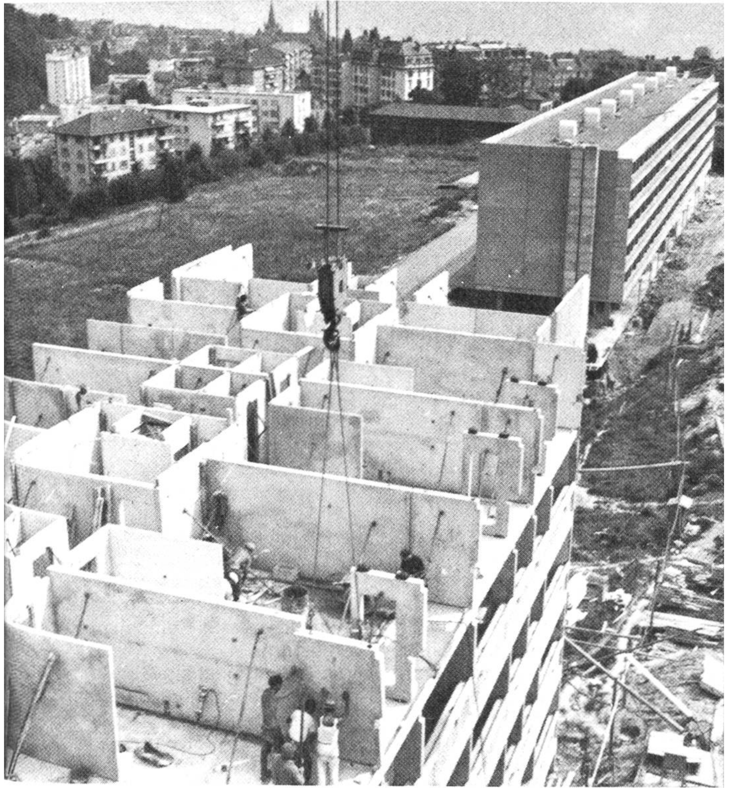
Versetzen und Richten der Wände
