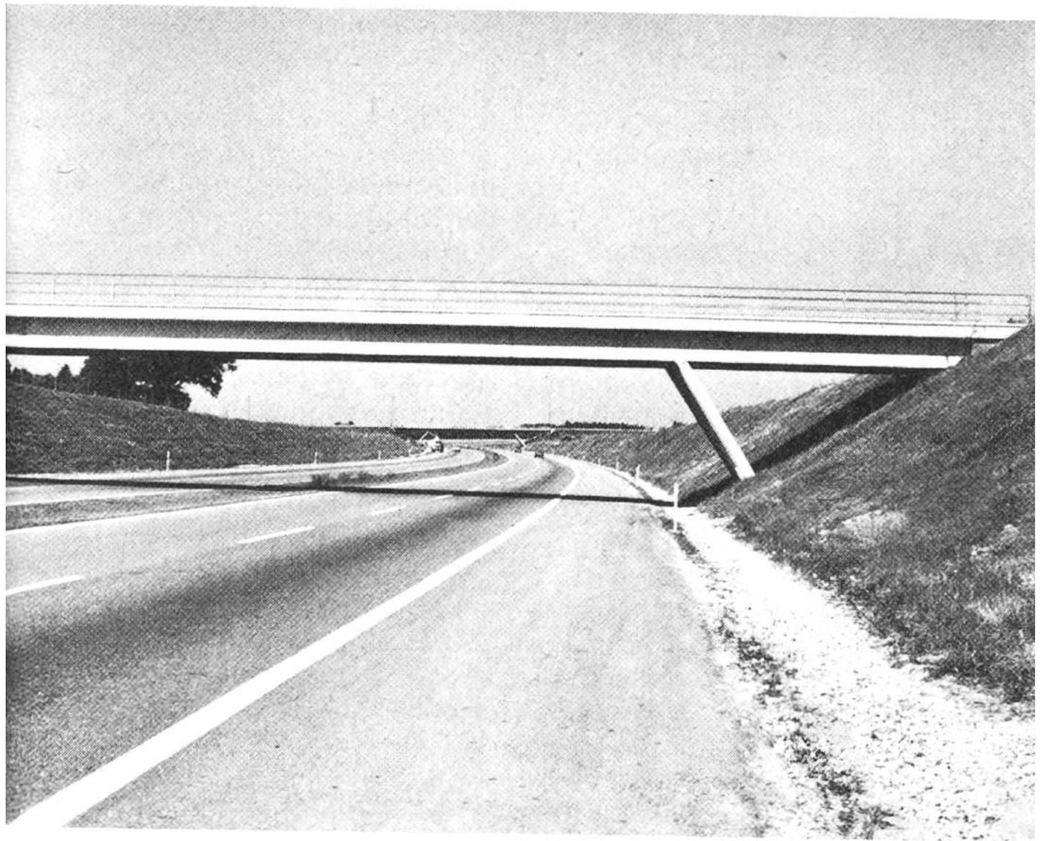
Autobahnüberführung der N 1
