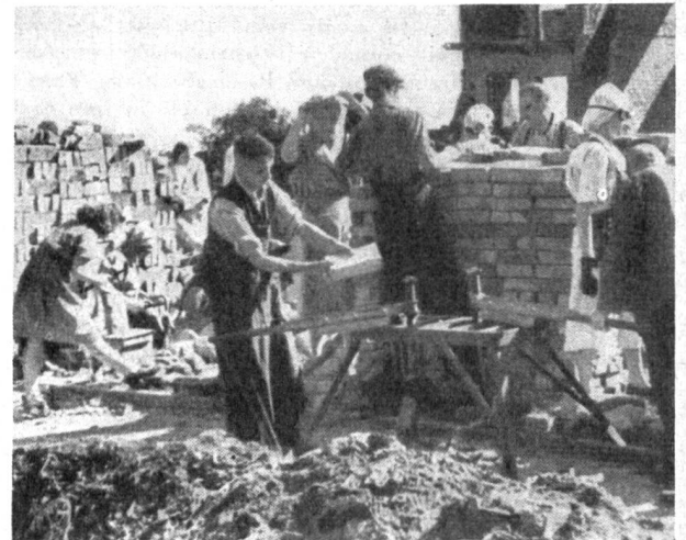
Abb. 2. Die Backsteine werden von Mörtel gereinigt.
