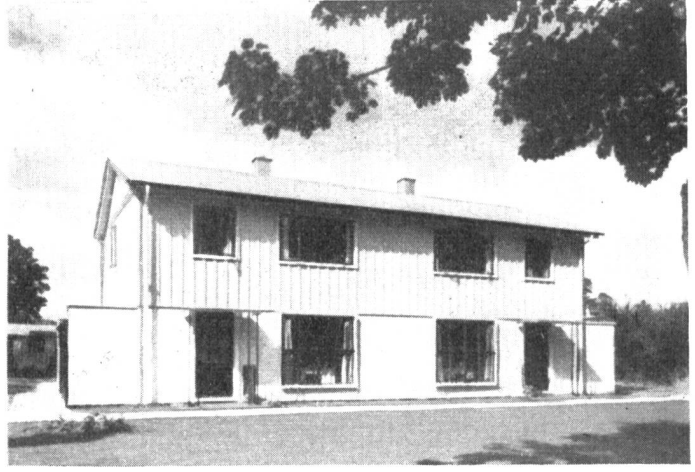
Abb. 1. Beispiel eines vorgefertigten Haustyps in Stahlskelett mit Plattenverkleidung.
