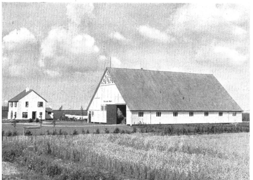
Abb. 7. Eine der ersten aus Einzelteilen (Beton- elementen) zusammengestellten Betriebs- scheunen für den Ackerbau im Nordost- polder; links davon das dazugehörige Bauernhaus. Im Laufe von acht Jahren sollen in dieser Gegend 2000 solcher Be- triebsscheunen fertiggestellt werden.
