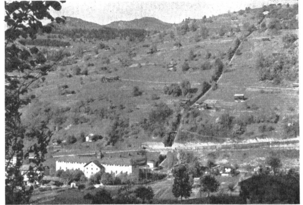
Abb. 4. Oft lässt es sich nicht vermeiden, dass die Strenge der Druckleitungen eines Hochdruckwerkes einen Einschnitt in die Landschaft bringt. (Zentrale Küblis.)
