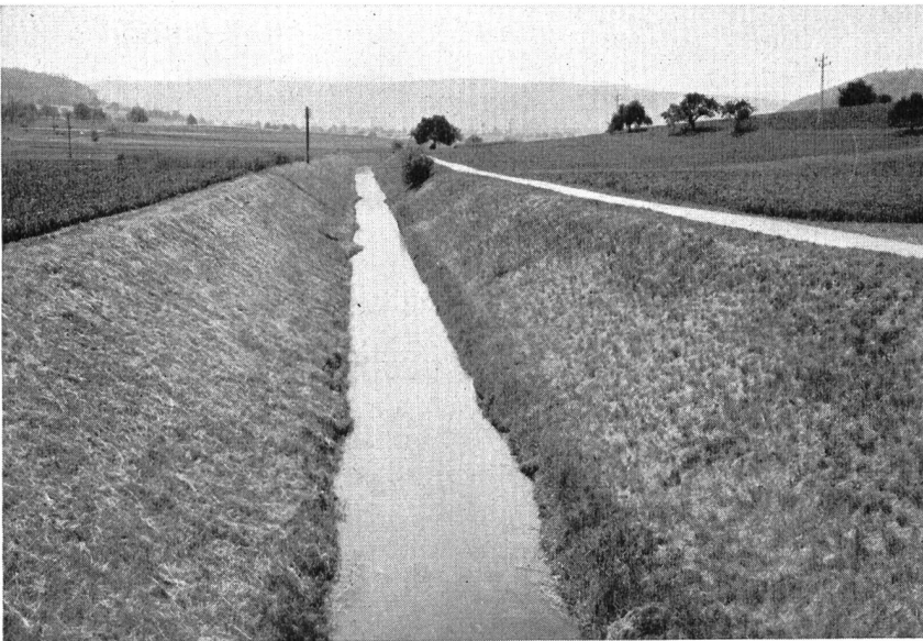
Abb. 2. Ein korrigierter Bachlauf; ohne Strauchbepflanzung durchschneidet er mit seinen harten Böschungen brutal die Landschaft.
