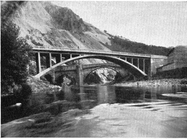
Fig. 5. Pont en ciment armé sur le Lignon (route nationale n° 88).
