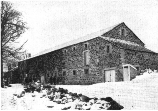
Fig. 3. Agrandissement et amélioration d'une habitation et d'une étable-grange dans la région du Mézenc: vue extérieure d'ensemble.
