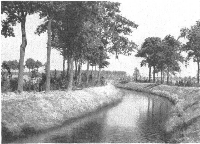
Abb. 7. Ein anlässlich einer Melioration erweitertes und saniertes Bachbett in den Niederlanden. Alte Bäume wurden soweit als möglich geschont und zusätzliche Bäume und Büsche angepflanzt. (Photo Staatsbosbeheer)
