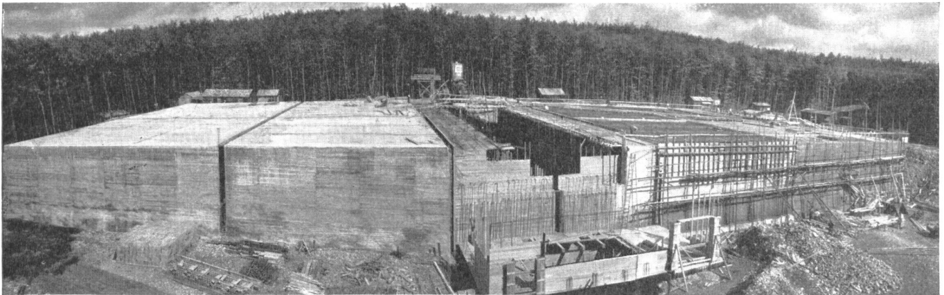
Abb. 8. Hochbehälter Aufhausen im Bau.
