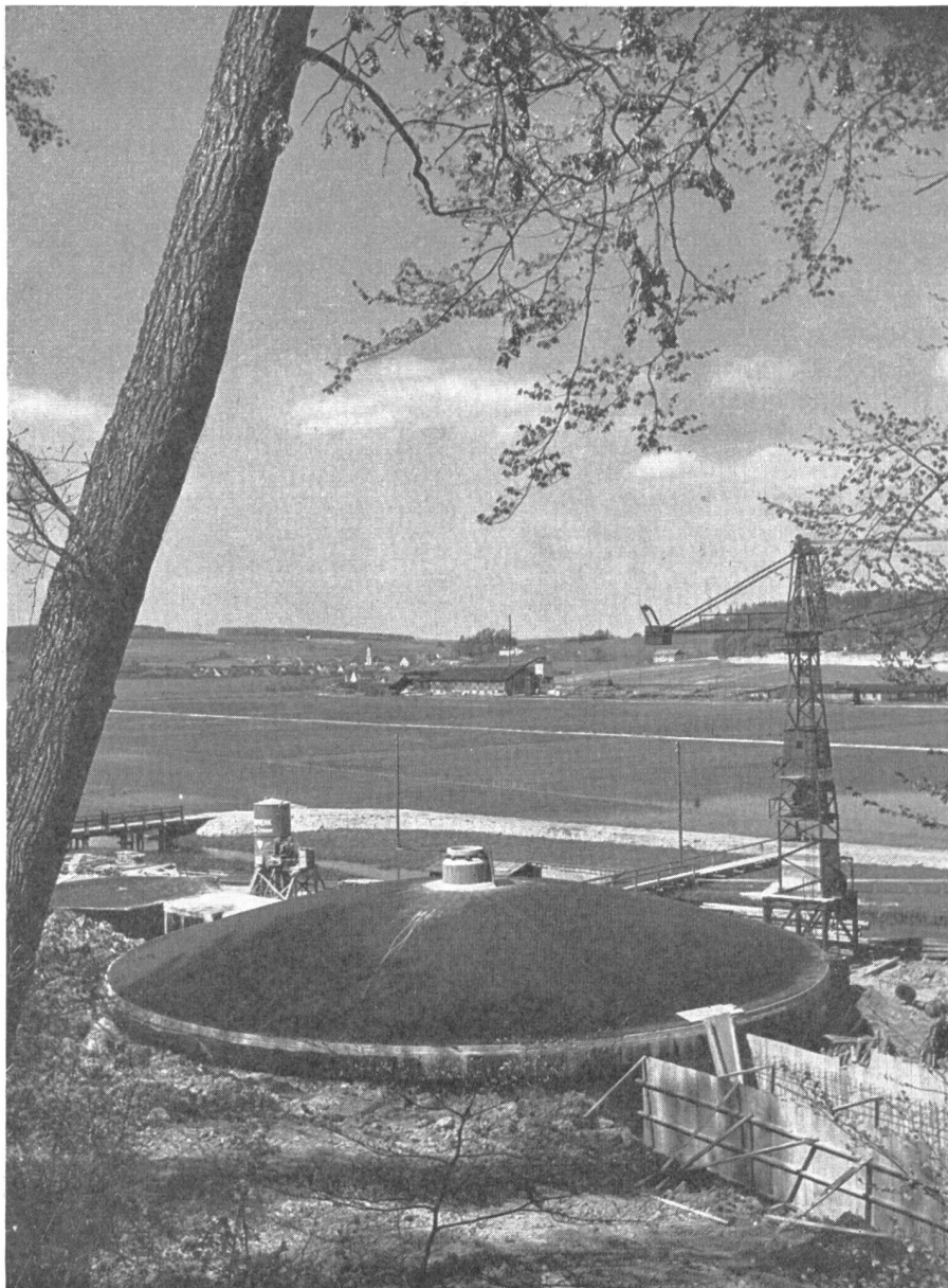
Abb. 7. Fassungsbauwerk über dem Buchbrunnen-Quelltopf.
