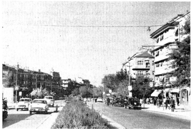
Abb. 2. Die Doppelfahrbahn des Atatürk-Boulevards durchzieht Ankara in 6 km Länge. Vorerst genügt sie noch der Verkehrsbelastung. Die wichtigsten Kreuzungen sollen in zwei Ebenen gelöst werden.
