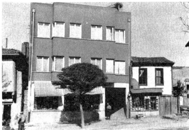
Abb. 5. Wo alte und neue Bauauffassung zusammentreffen, gibt es meist eine unruhige Fassadenabwicklung.
