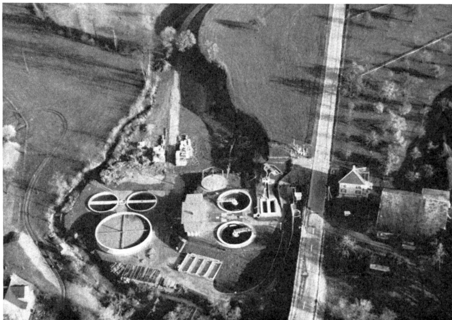
Abb. 5. Kläranlage Wil SG: Flugaufnahme von Westen.
