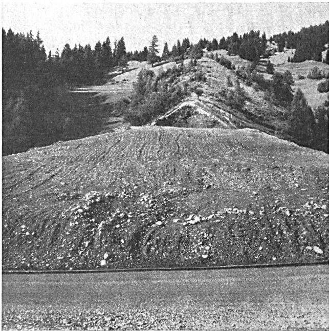
Abb. 8. Schuttdeponie an der Strasse Chur - Arosa.
