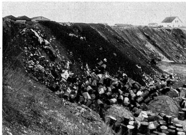
Abb. 2. Auffüllung der Kiesgrube mit Chemieabfällen, welche zum Teil in den auf dem Bild sichtbaren Eisenfässern antransportiert wurden.
