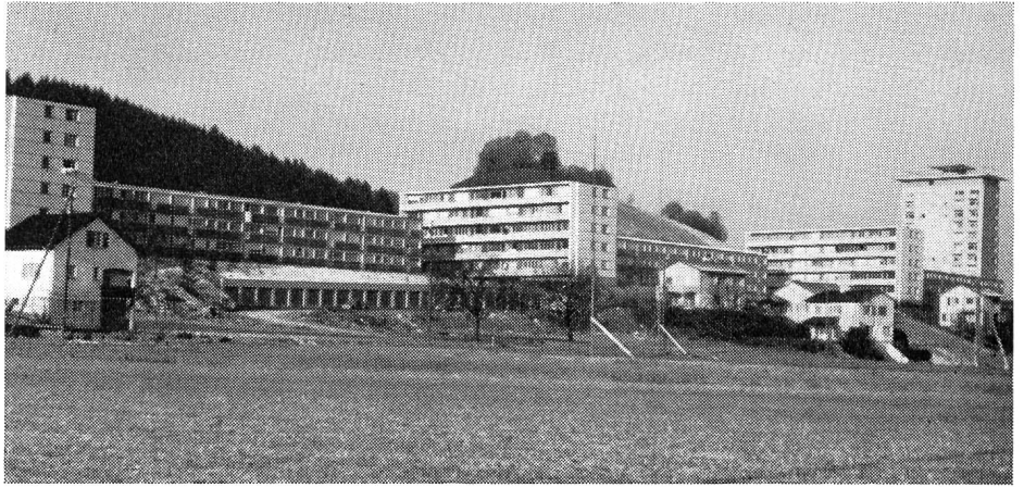
Abb. 13. Südostansicht mit den drei quer zum Hang gestellten Fünfgeschossern. Einer der von der Gyrhaldenstrasse zugänglichen, unter Terrain liegenden Garagentrakte ist gut sichtbar.
