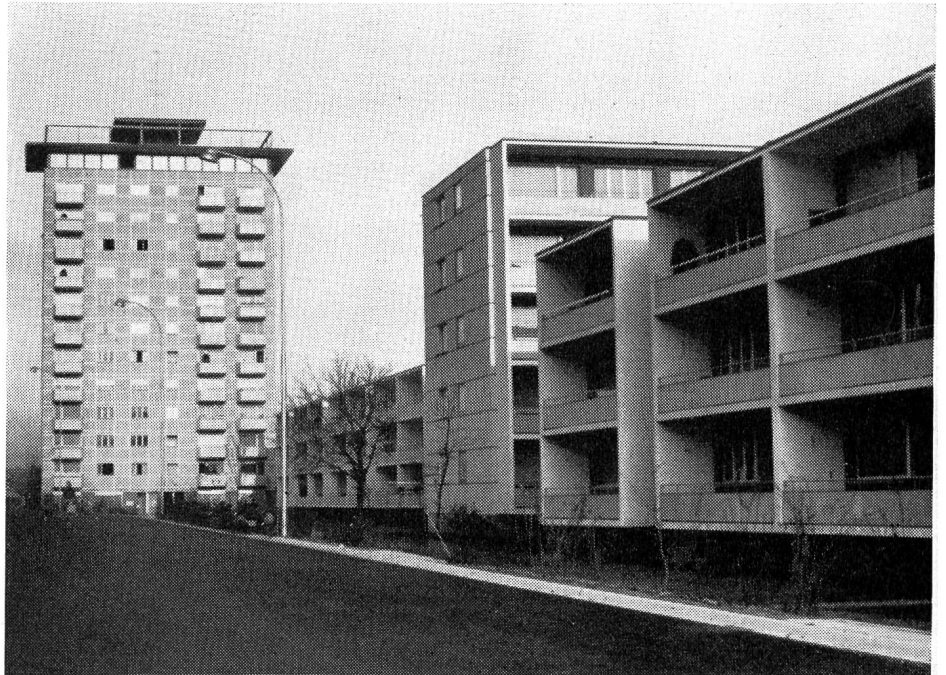
Abb. 14. Südansicht mit dem von der Blocküberbauung «aufgefangenen» Hochhaus. Die eher städtische Haltung der Ueberbauung wird durch die kürzlich eingereichten Projekte im Westteil der Gyrhalde noch verstärkt werden. Im Endausbau darf ein akzeptables Neuartier erwartet werden.
