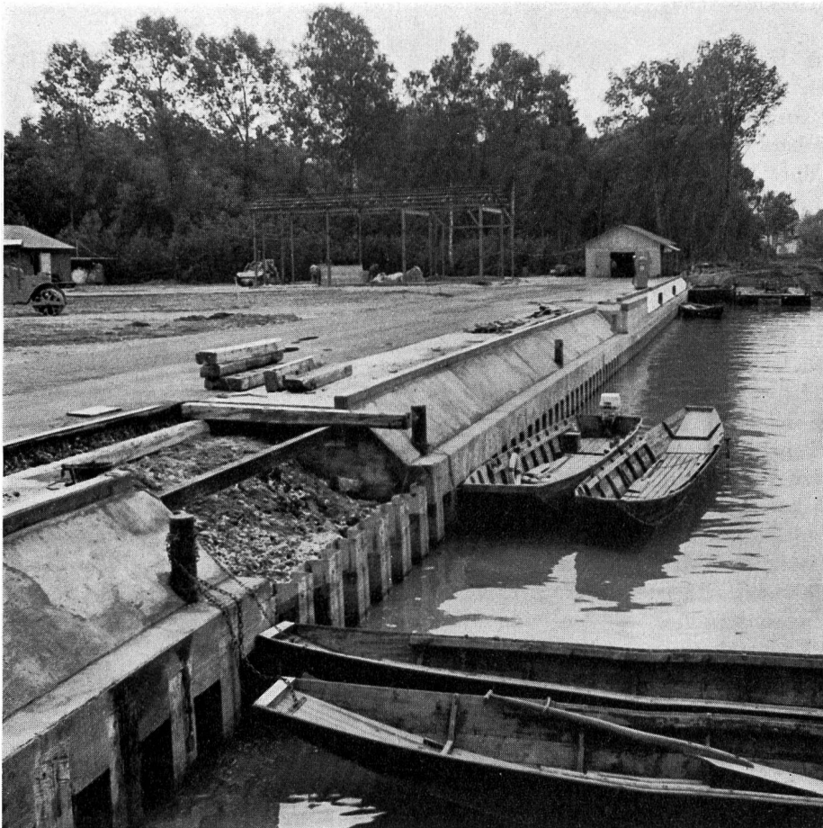
Abb. 15. Der neue Hafen und Umschlagsplatz in Sugiez.
