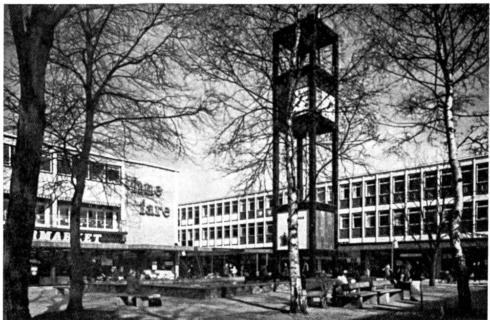
Abb. 10. Hauptplatz von Stevenage mit zwei- und dreigeschossigen Büro- und Ladenbauten. Die Schaufenster sind durch ein kontinuierliches Band von Vordächern verbunden
