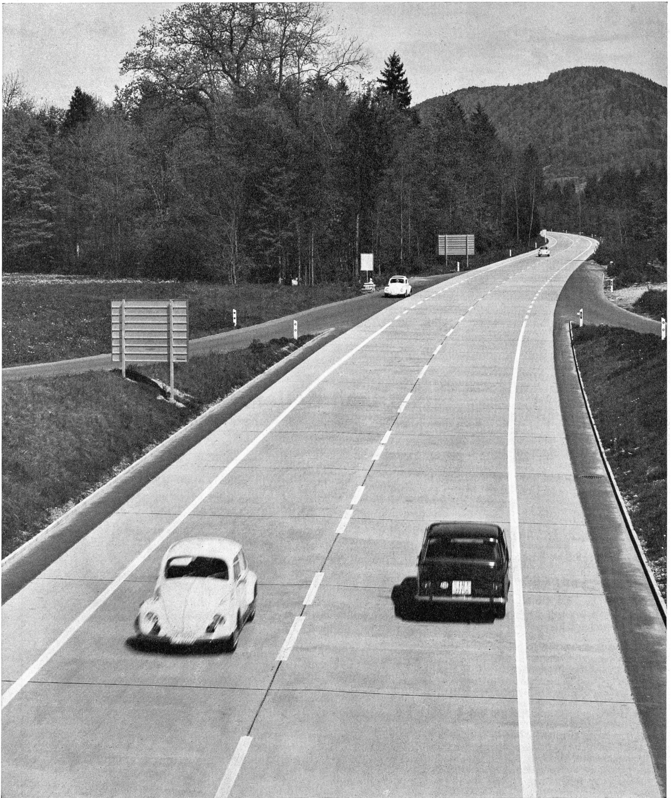
Talstrasse Luzern-Bern, Umfahrung Malters LU, Betonbelag
