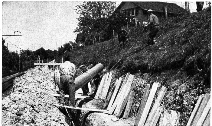
KALIDUR-Kanalisationsrohre, verlegt im Bahneinschnitt
