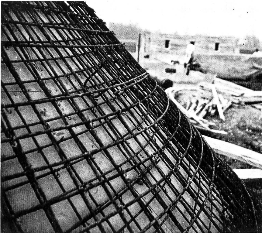
Abb. 2. Stahlarmierung auf Airex® verlegt.
