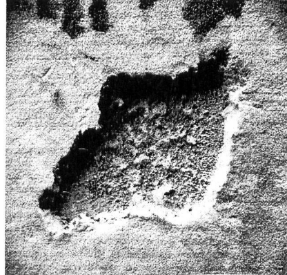
Abb. 3. Airex®-hart wurde von dem vibrierten Beton weggerissen.
