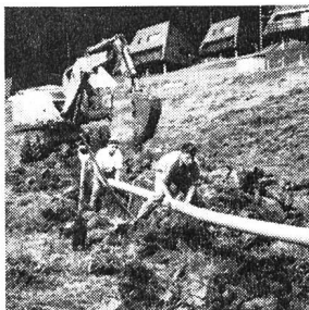
Kanalisation Schwyz: Rothenturm
