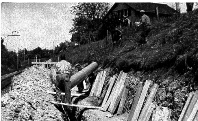
KALIDUR-Kanalisationsrohre, verlegt im Bahneinschnitt
