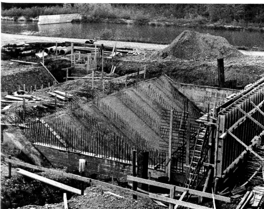
Abb. 2. Noch wird hier gearbeitet, doch schon bald werden die Schneckenpumpen montiert sein und ihre Arbeit aufnehmen können (Aufnahmen: maw.)
