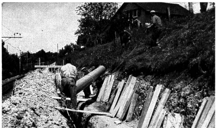
KALIDUR-Kanalisa-tionsrohre, verlegt im Bahneinschnitt
