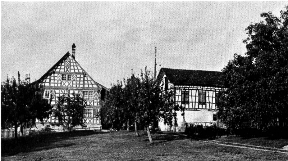
Abb. 2. Riegelhäuser trifft man vor allem in den Gebieten, wo die Eichenwälder früher viel verbreiteter waren als heute; die Holzkonstruktion ist bei alten Häusern ganz aus Eichenholz. So weist dieser Haustyp eine direkte Beziehung zur Landschaft auf (Zihlschlacht TG).
