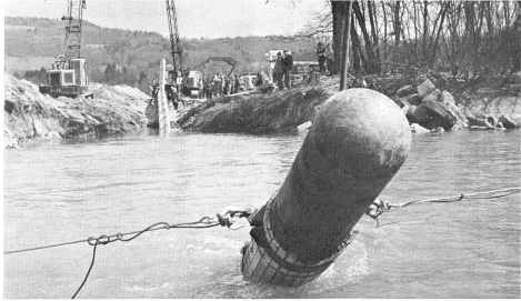
Abb. 3. Verschweisste Leitung vor Göslikon Abb. 4. Verlegearbeiten der Swissgas-Leitung bei Lenzburg
