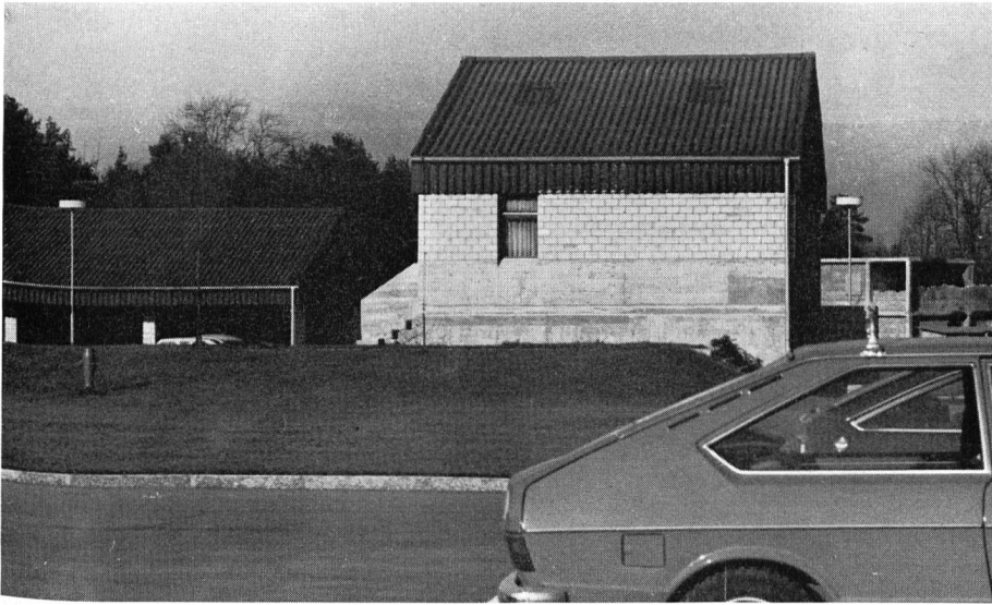
Abb. 4. Gebäude F enthält die Unterkunft für den Platzwart
