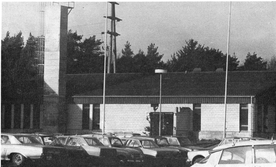
Abb. 2. Das Gebäude B: Links neben dem Kamin der grosse Speisesaal, rechts vom Eingang Büro und Krankenzimmer
