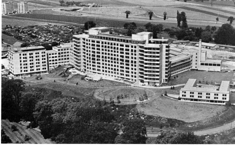
Abb. 1. Kantonsspital Freiburg, Blick von Südosten: Im Vordergrund das Bettenhaus, links davon der Behandlungsbau mit nachfolgendem Personalhaus, rechts im Hintergrund der Wirtschaftstrakt
