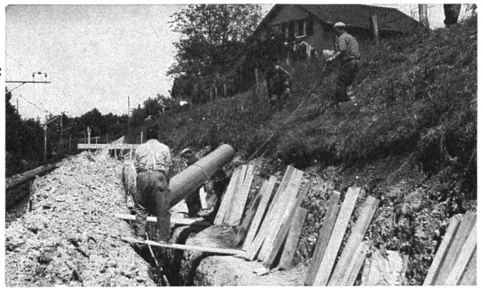
KALIDUR-Kanalisationsrohre, verlegt im Bahneinschnitt
