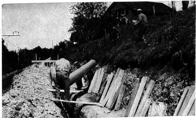
KALIDUR-Kanalisationsrohre, verlegt im Bahneinschnitt
