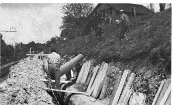
KALIDUR-Kanalisationsrohre, verlegt im Bahneinschnitt
