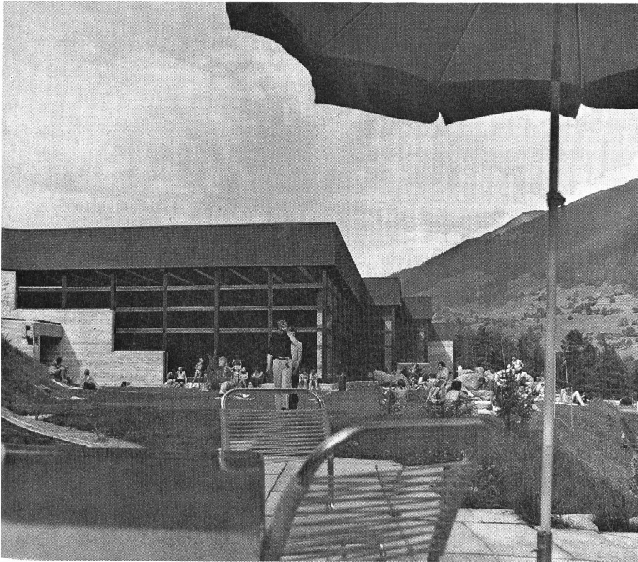
▲ Das Hallenbad Fiesch. Vorfabrizierte Decken-, Träger- und Fassadenelemente auf Unterbau und Ortsbeton bilden die Struktur. Das Fassadenstirnband ist mit schwarzen Schiefnern «Eternit» verkleidet
