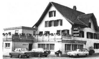
Fassadensanierung mit vorgehängten Fassadenschiefern «Eternit»
