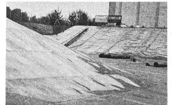
Das Grundwasser unter Mülldeponien wird sicher und dauerhaft geschützt durch Sarnafil FP Kunststoff-Dichtungsbahnen.
