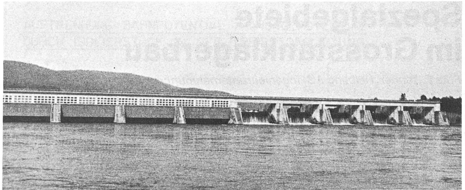
Abb. 2. ENEL Italien – Kraftwerk Montjovet. Aussenanstrich. Vorbehandlung: Sa 3. Beschichtungsaufbau: 2× Vinoxink R, 2× Afratop A 70.
